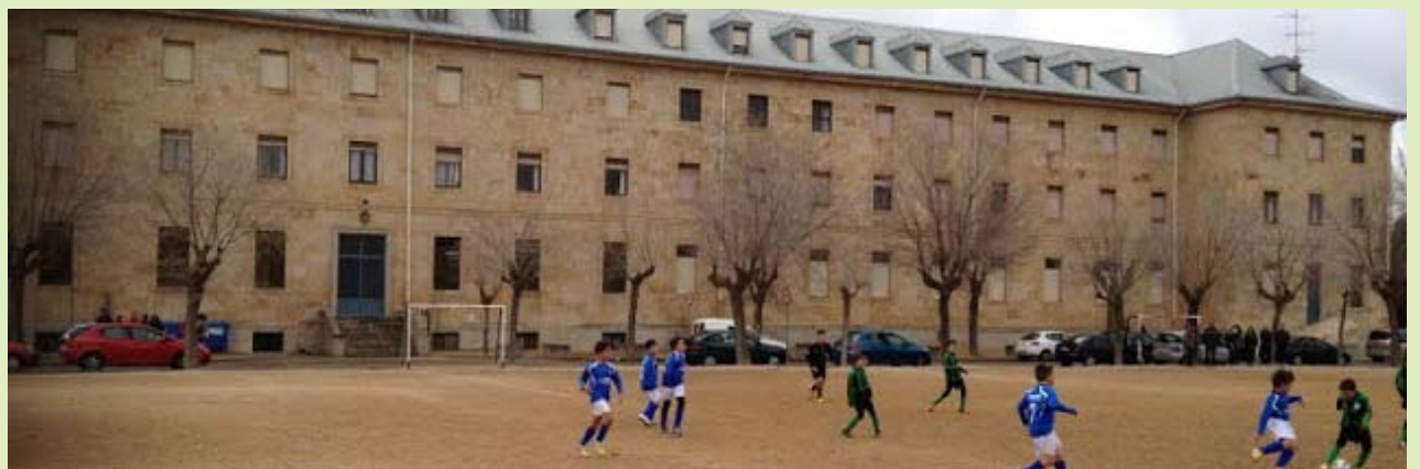
Campo de fútbol ubicado en el patio del colegio San Agustín de Salamanca.
