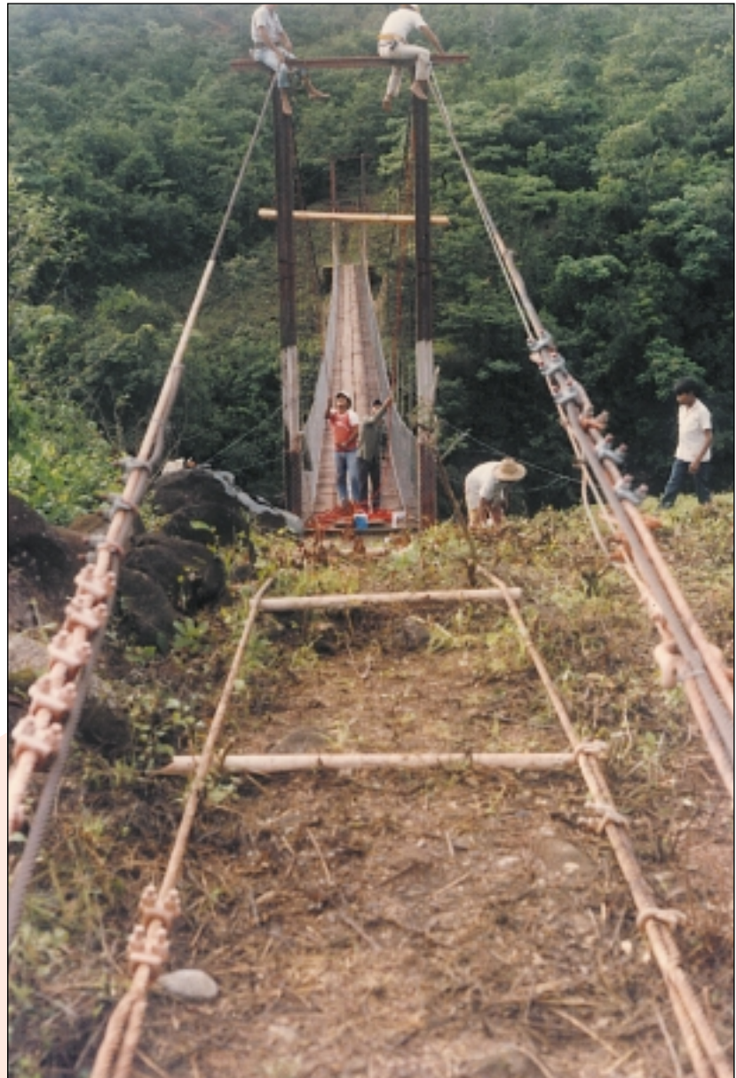
Construcción del puente del P. Moisés y “alta seguridad laboral”.
