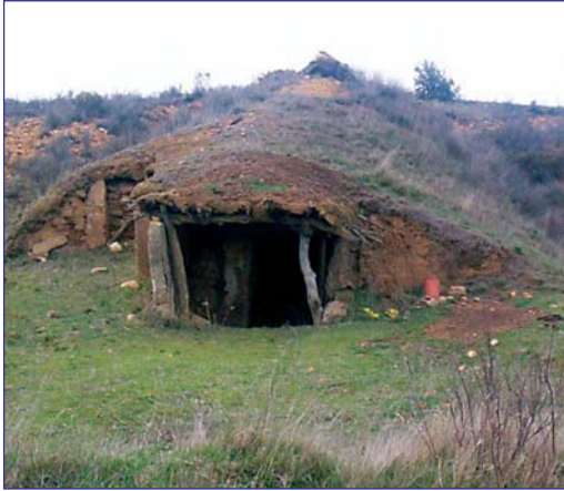
Bodega en barranco.
