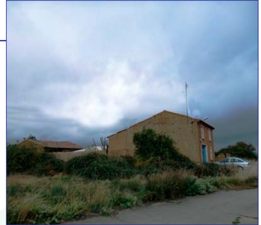
Casa típica construida con mortero de tierra y ladrillo en fachada.
