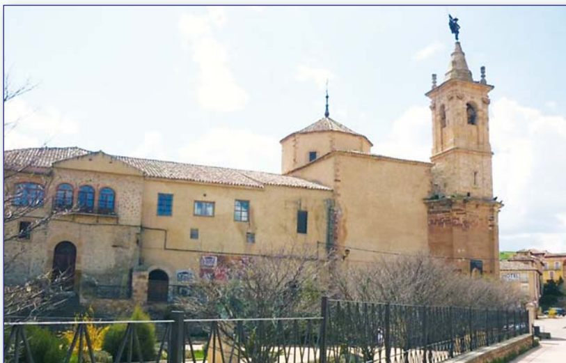
Fig. 1. Vista panorámica del Convento de San Francisco
